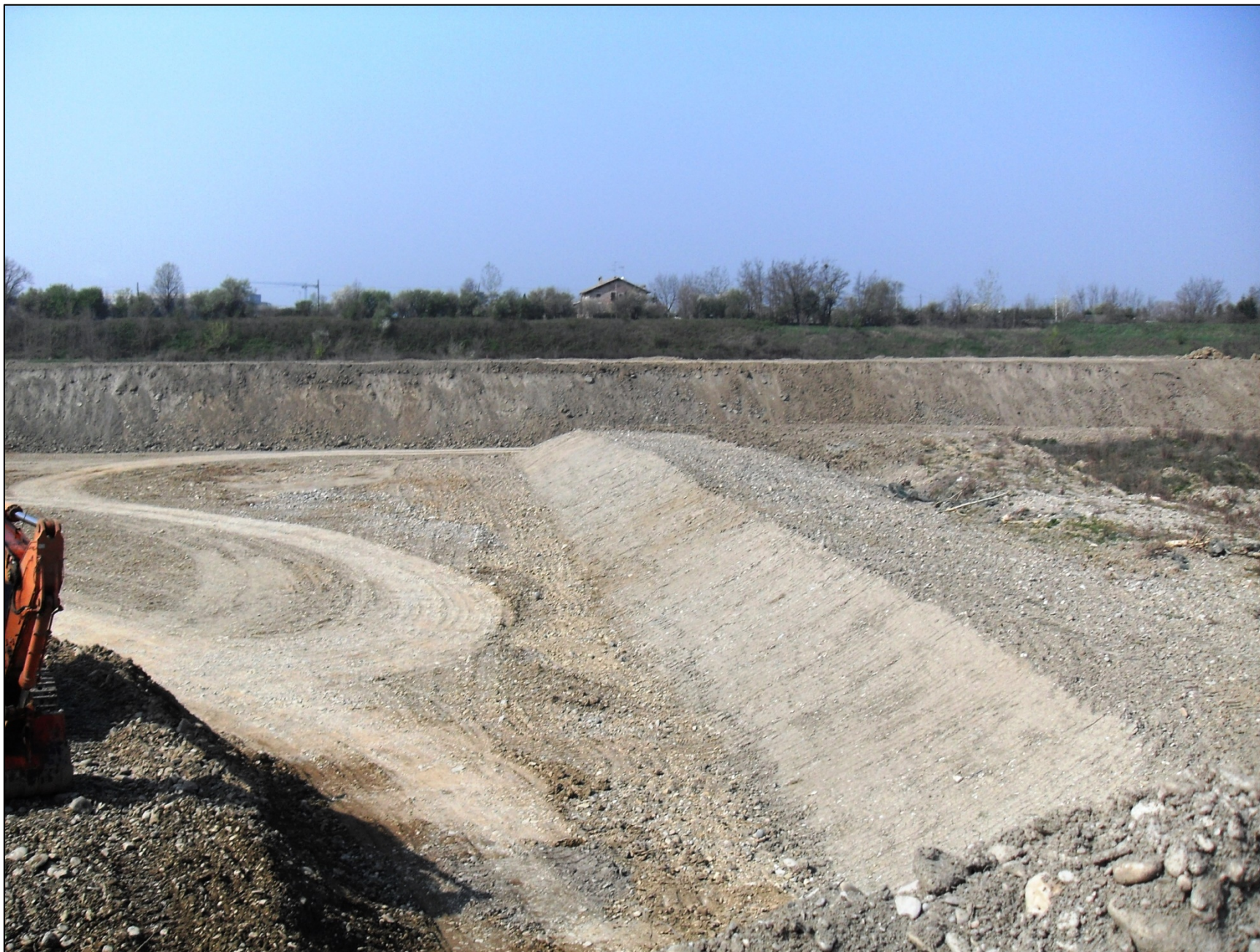
- FOTO 18: Panoramica, vista da Est verso Ovest, dello stato di fatto di Cava “Valentini” a ridosso del confine sud di Cava “San Lorenzo” dell’Emiliana Conglomerati S.p.A.. Come è possibile rilevare, lungo il confine con Cava “San Lorenzo” viene rimosso l’intero diaframma di separazione tra le due cave per poter abbassare la rete di recinzione.
