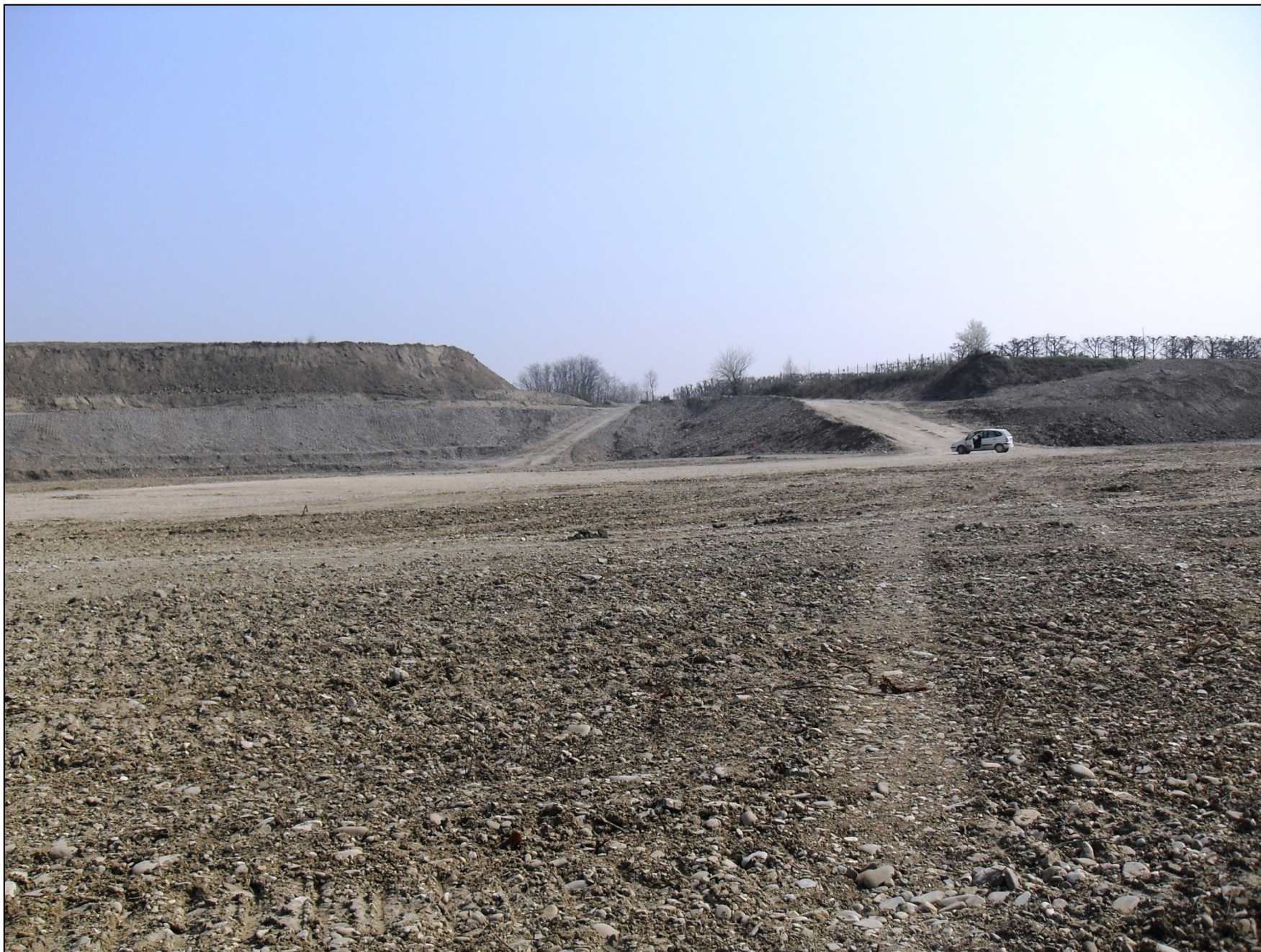
- FOTO 9: Bella panoramica, vista da Ovest verso Est, dello stato di fatto di Cava “Valentini” nella zona centrale di questa unità produttiva. In alto, a sinistra della foto, in bella evidenza la parte ancora vergine dell’area di cava con sopra il grosso cumulo di terra; sulla destra, la rampa per il trasporto al “Cantiere Brugnola” del materiale ghiaioso estratto dalla cava.
