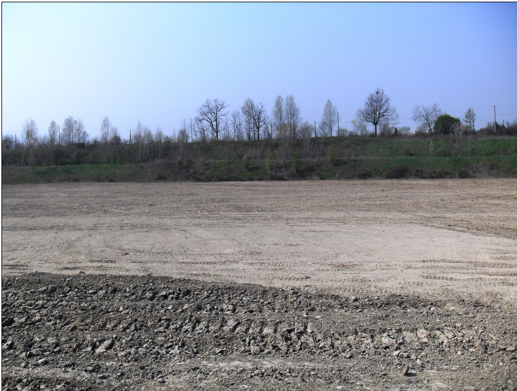
- FOTO 5: Panoramica, vista da Est verso Ovest, dello stato di fatto dell'attuale fondo scavo a -10 m dal p.c. originario nella zona meridionale dell'area di Cava "Valentini". Nella parte alta della foto sono chiaramente visibili le due parti di scarpata che fiancheggiano rispettivamente Via Bassa, sul lato ovest, ed il viottolo che porta alla Casa Mazzacani, sul lato sud.
