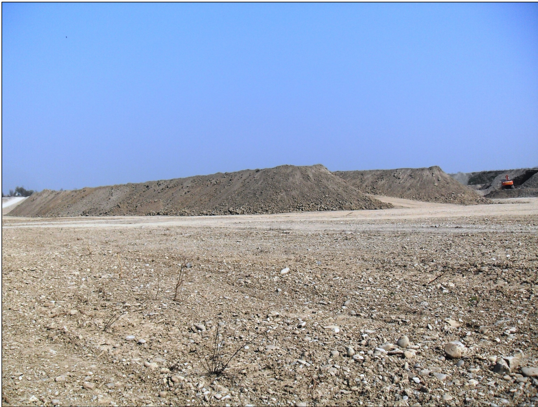
- FOTO 6: Panoramica, vista da Sud/Ovest verso Nord/Est, dello stato di fatto dell'attuale fondo scavo a -10 m dal p.c. nella zona centrale di Cava "Valentini". Il cumulo di terra visibile nella foto è parte del materiale terroso rimosso dal più grande cumulo presente sulla parte di area ancora allo stato vergine, nella zona di cava più ad est, al fine di poterne scavare la ghiaia sottostante.
