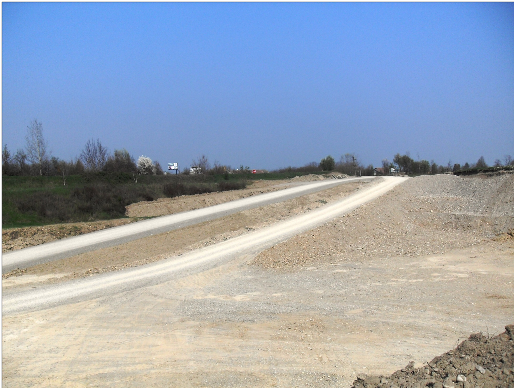
- FOTO 2: Primo piano delle due rampe che, a partire dall'accesso di Cava "Valentini" sulla S.P.51, portano all'attuale fondo scavo posto alla quota di -10 m dal p.c. originario. La rampa alla sinistra della foto, costruita di recente in terra, è stata realizzata per poter scavare il materiale ghiaioso che dà corpo alla rampa sulla destra, in attesa dell'approvazione del nuovo Progetto di Coltivazione a -20 m dal p.c..
